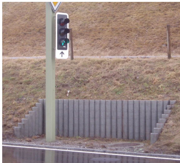
Bild 4: Palisaden als Hangsicherung
