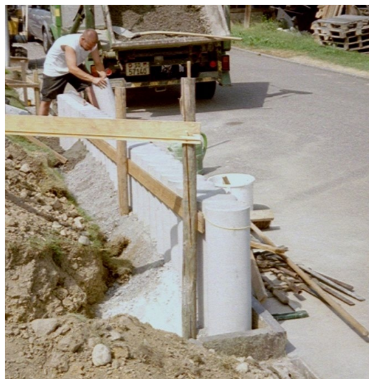
Bild 13: Richtlatte als Verlegehilfe für den Einbau von Palisaden
