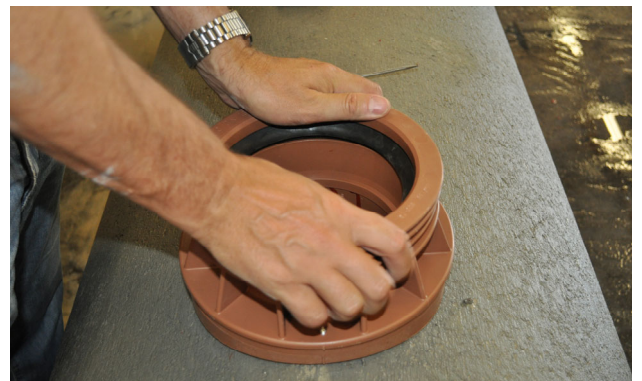
Bild 12: Steckanschlussstück einpressen
