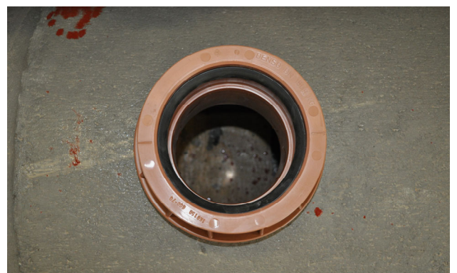
Bild 13: Keilgleitdichtung und Spitzende mit Gleitmittel einschmieren
