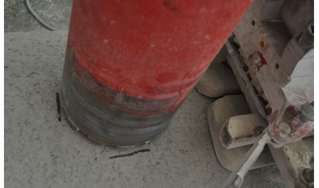
Bild 6: Korrekt montiertes Kernbohrgerät
