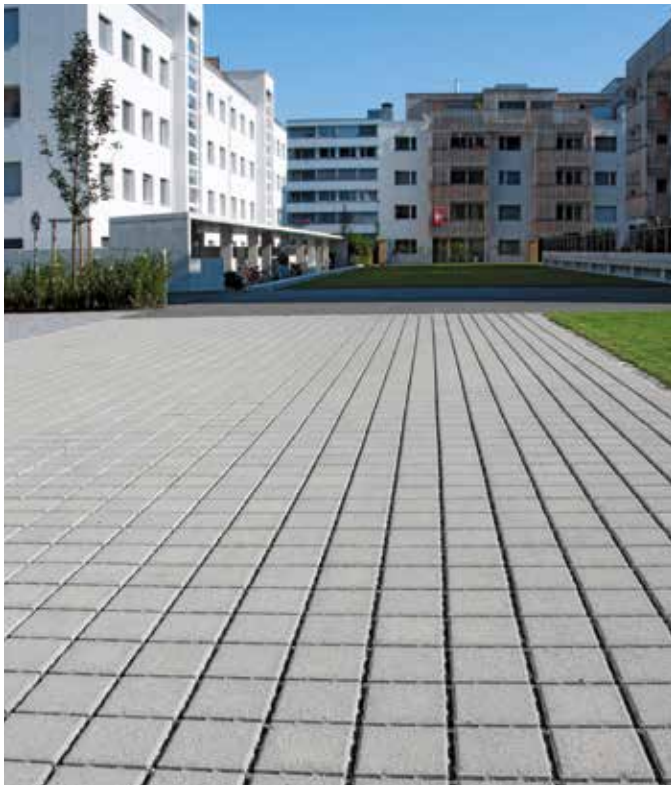
Parkfläche mit SPLITT Ökostein
