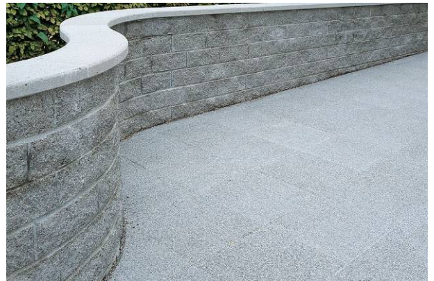
Bild 3: Mauer mit Radiusspaltsteinen
