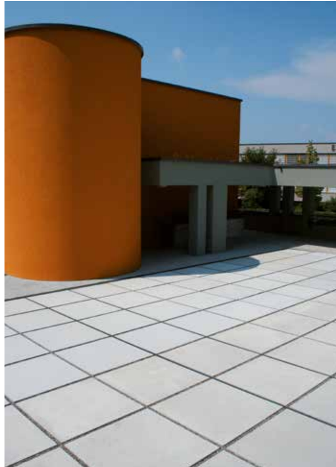
Optische Raumerweiterung mit grossflächigen Platten
