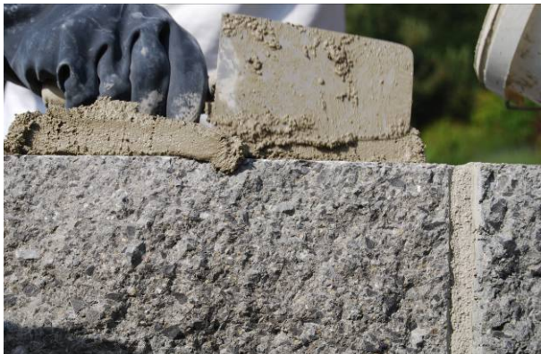
Bild 62: Erstellen der Mörtelvorlage
