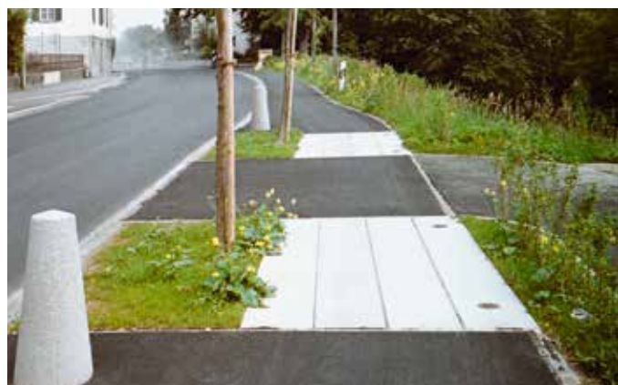
Wurzelbrücke mit Wehrsteinen als Anfahrtschutz
