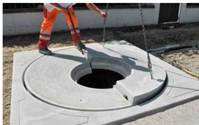
Versetzen der COPAL Betonabdeckung
