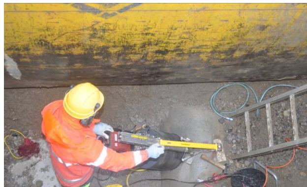
Bild 6: Korrekt montiertes Kernbohrgerät
