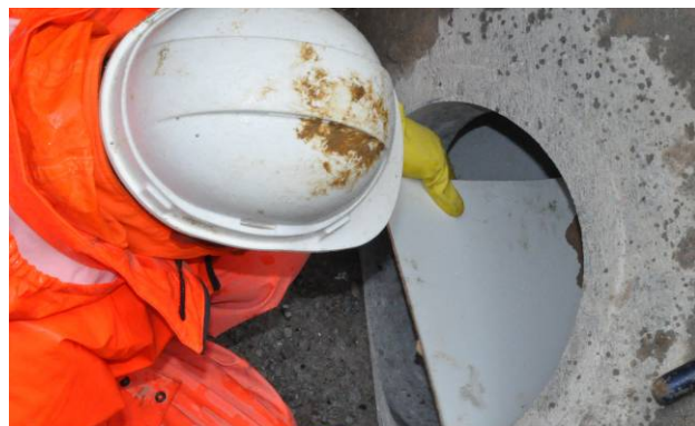
Bild 8: Einlegen einer Unterlage
