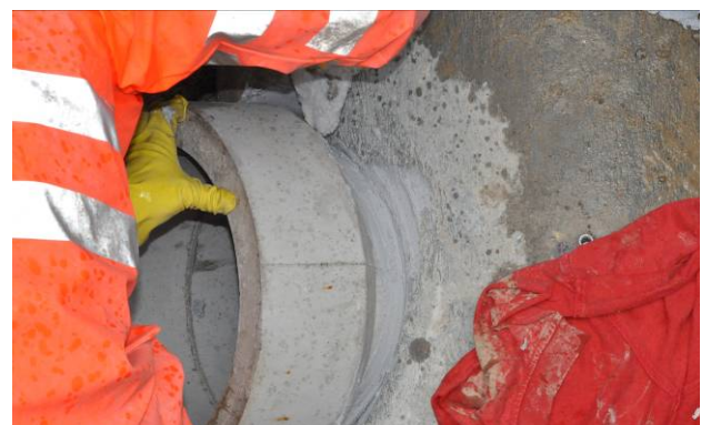
Bild 13: Bilden der äusseren Kehlkannte
