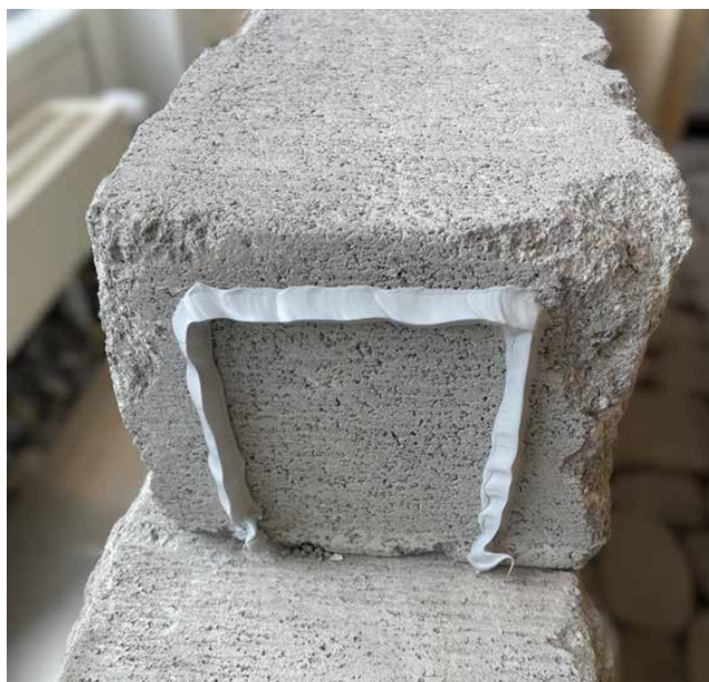
Illustration 2 : Encollage d'une tête de brique
