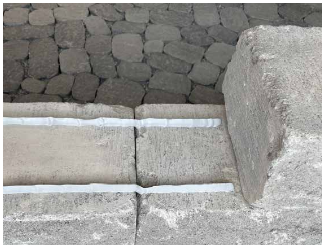
Illustration 1 : Encollage d'une rangée
