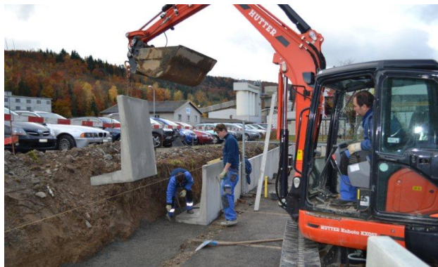
Bild 35: Versetzen der Winkelplatten
