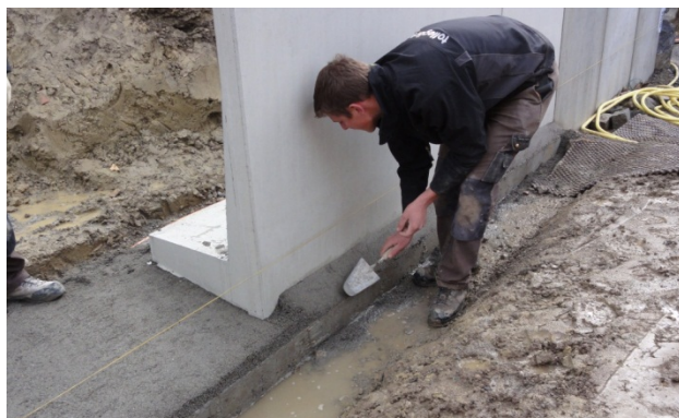
Bild 37: Erstellen der Fundamentnocken
