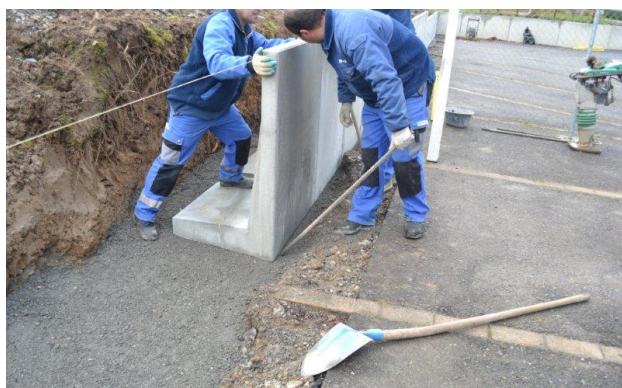
Bild 36: Richten der Winkelplatte
