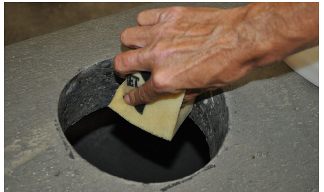
Bild 8: Bohrlochwandung mit Wasser befeuchten
