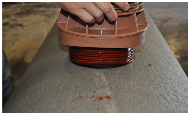
Bild 11: Steckanschlussstück ansetzen, Markierung beachten
