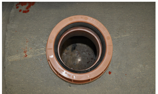
Bild 13: Keilgleitdichtung und Spitzende mit Gleitmittel einschmieren
