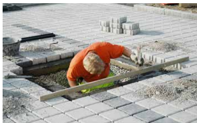
Erstellen eines Auflagers auf Fundamentrahmen
