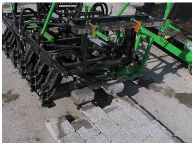
Bild 39: Maschinelle Verlegung mit OPTIMAS Verlegemaschine
