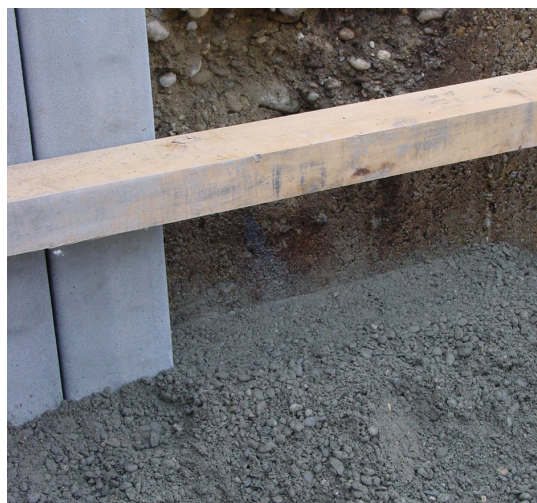
Bild 7: Vorbereitete Sohle mit Richtlatte
