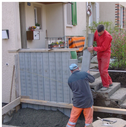
Bild 12: Einbau Palisaden
