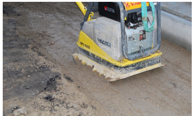
Bild 35: Verdichten nur mit leichten Verdichtungsgeräten
