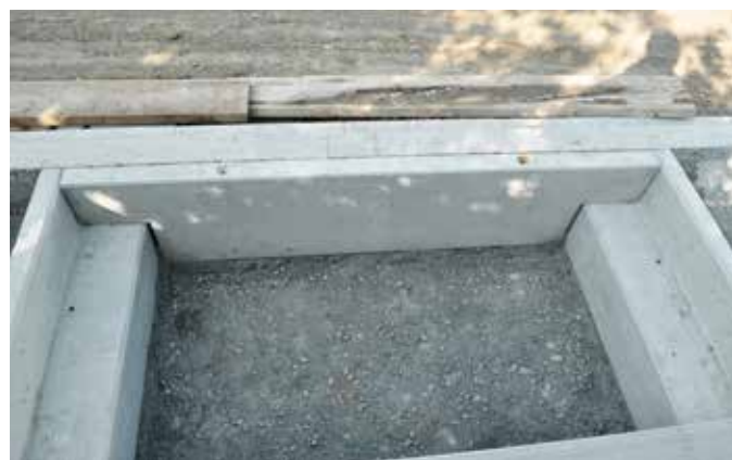
Versetztes F+F Abschlusselement
