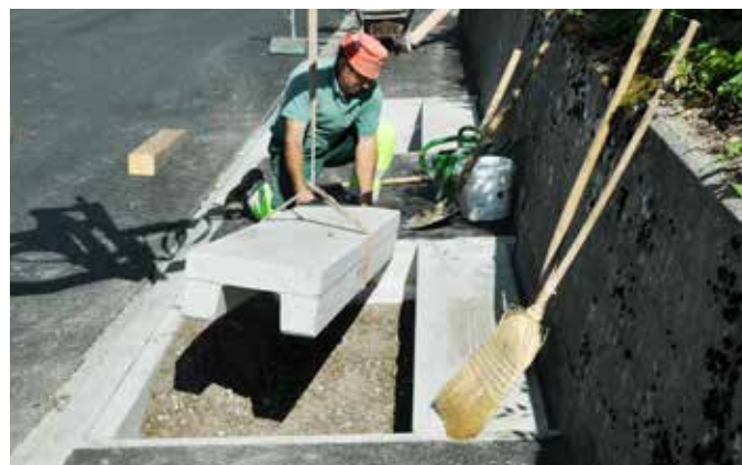
Versetzen der F+F Abdeckelemente
