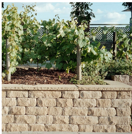
Bild 2: SANTURO® Weinbergmauer mit Abdeckplatte
