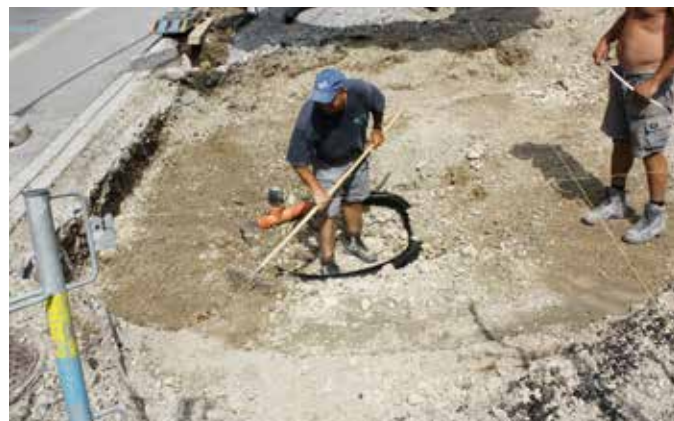
Erstellen der Auflageflächen
