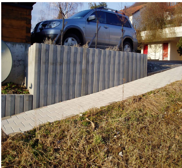
Bild 3: Rechteckige Palisaden als Böschungssicherung
