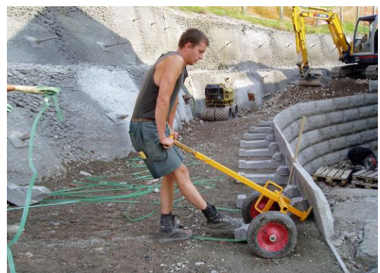
Bild 17: LOCK+LOAD Versetzwagen
