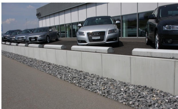
Bild 1: ROZTEC® MIDI Winkelplatten als Böschungssicherung
