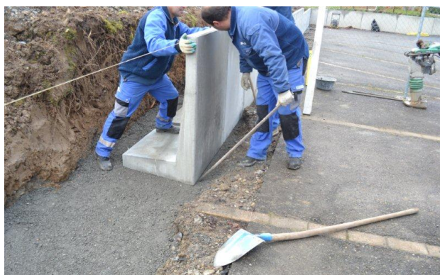
Bild 36: Richten der Winkelplatte
