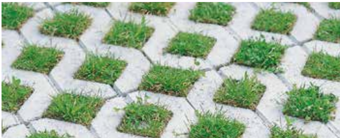
Versickerung durch eingelassene Kammern (Rasengittersteine)
