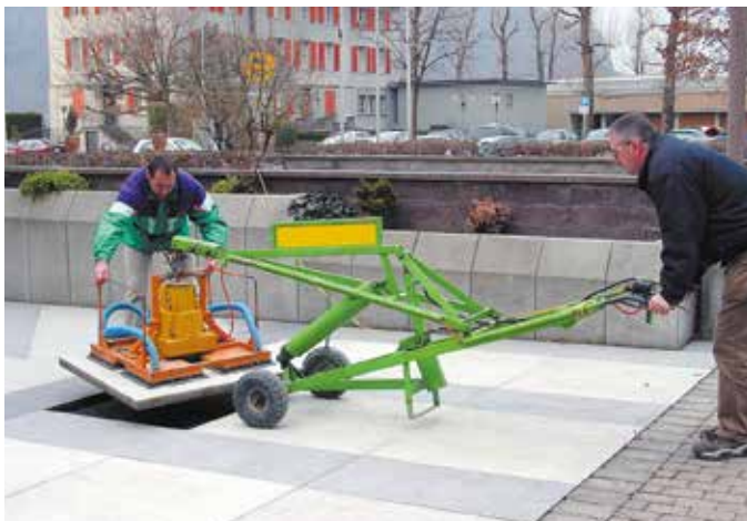
Plattenverlegegerät PRESTO
