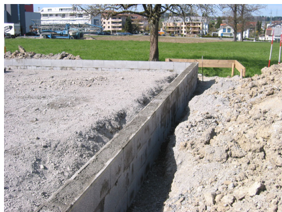
Bild 2: SCHALIT Schalungsstein als Frostriegel
