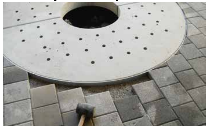
Versetzte TREETUB Betonabdeckung 2-teilig
