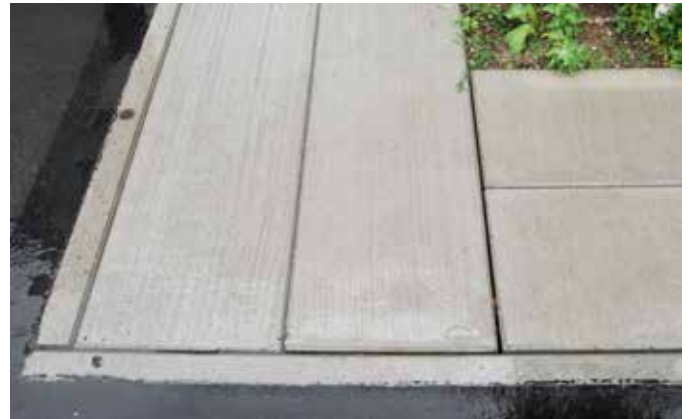
Wasserzufuhr durch Fugen
