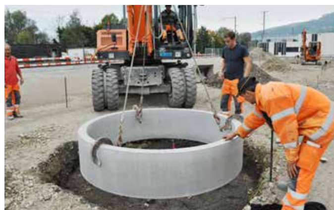
Versetzen des TREETUB Betonrohres auf das Streifenfundament
