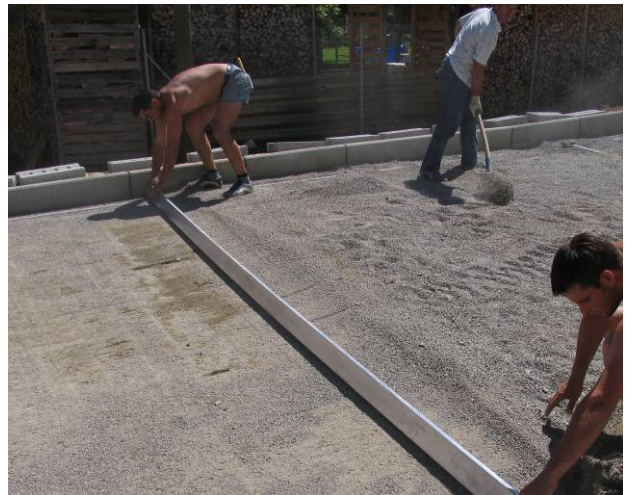
Bild 33: Abziehen der Bettungsschicht
