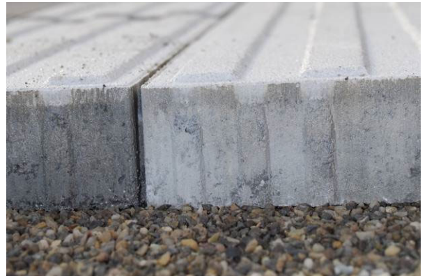
Bild 37: Verlegte CARENA® Sicherheitsliniensteine H = 6 cm
