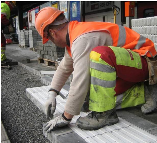
Bild 36: Verlegen der CARENA® Sicherheitsliniensteine H = 8 cm
