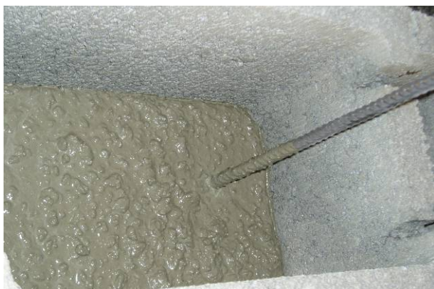
Bild 51: Füllhöhe bei der obersten Lage pro Betonieretappe
