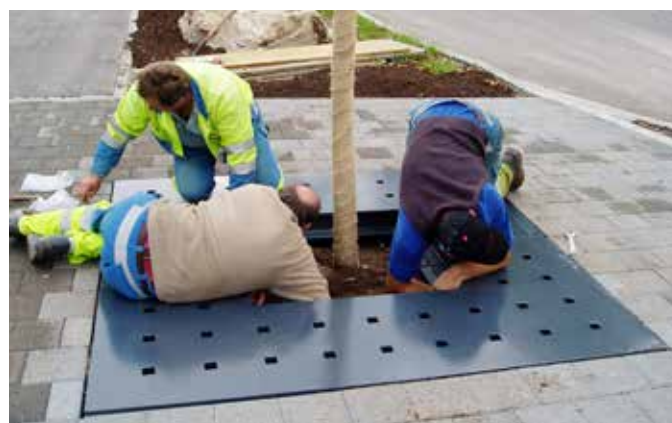
Montieren der Verbindungsschrauben
