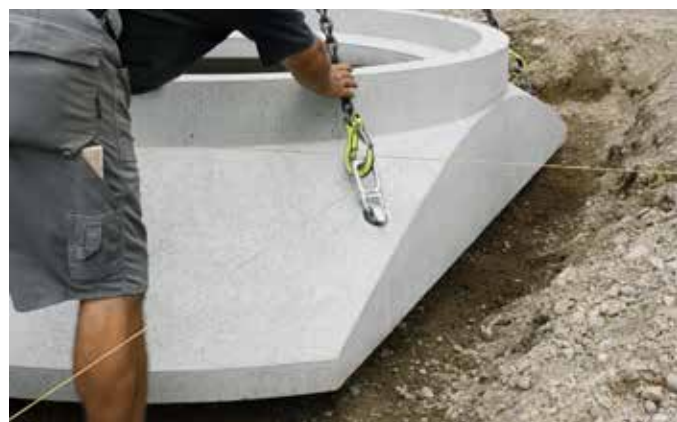
Versetzen des Basiselementes
