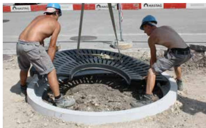
Versetzen der Gussroste
