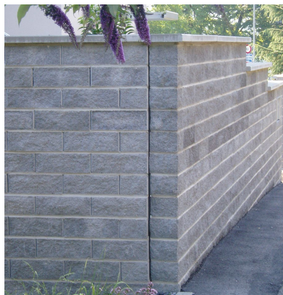
Bild 41: Dilatationsfuge (Produktneutral)
