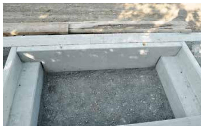
Versetztes F+F Abschlusselement
