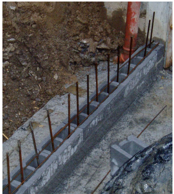
Bild 11: Horizontale und vertikale Bewehrung (Produktneutral)
