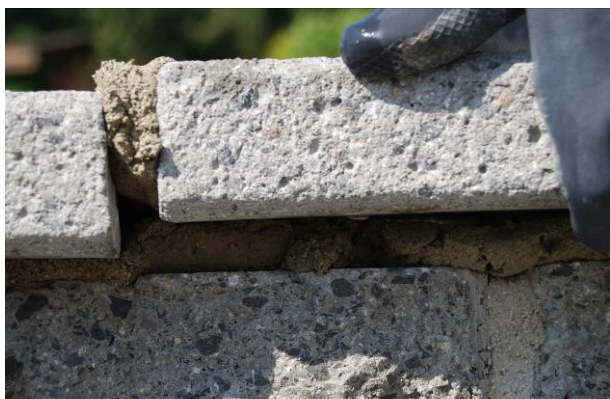
Bild 63: Versetzen der Abdeckplatten
