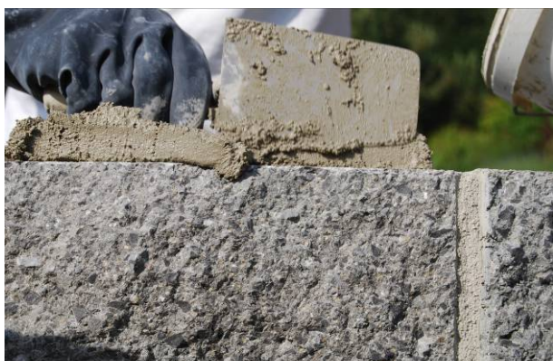
Bild 62: Erstellen der Mörtelvorlage
