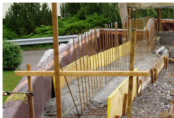
Bild 35: Fundament mit Anschlussbewehrung
