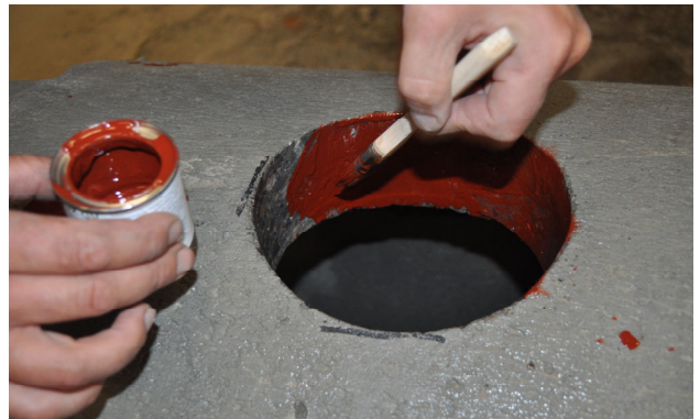
Bild 10: Auftragen von DENSONOX GV auf Bohrlochwandung
