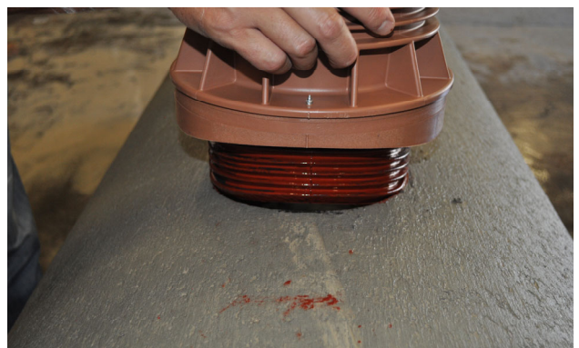
Bild 11: Steckanschlussstück ansetzen, Markierung beachten
