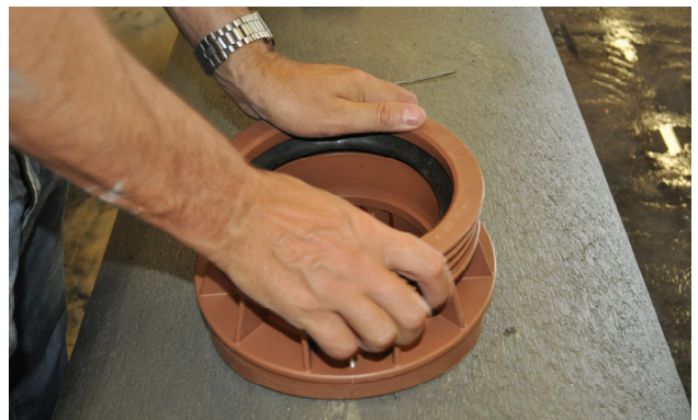
Bild 12: Steckanschlussstück einpressen
