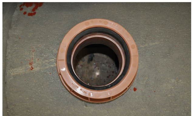
Bild 13: Keilgleitdichtung und Spitzende mit Gleitmittel einschmieren
