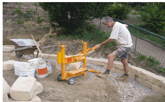
Bild 35: Arbeiten mit Steinspalter
