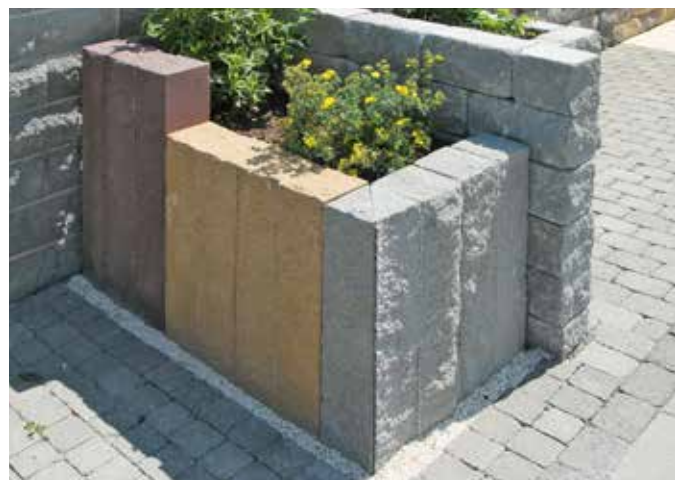
Eckelemente entstehen durch Gehrungsschnitte aus Standardelementen.
