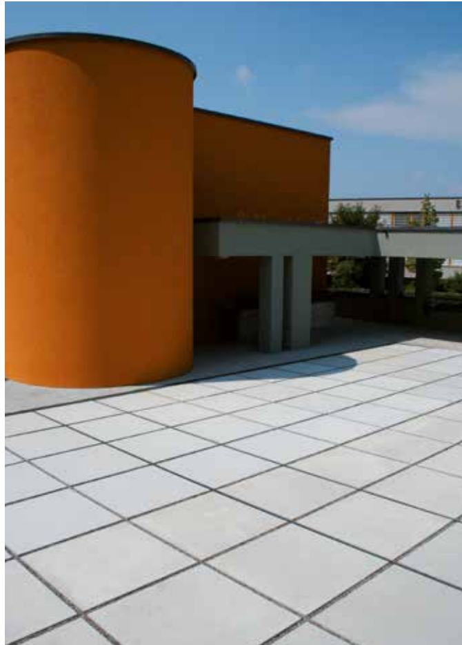
Optische Raumerweiterung mit grossflächigen Platten
