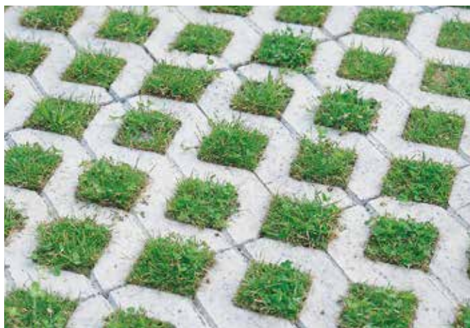
Rasengitterstein mit Versickerung durch eingelassene Kammern
