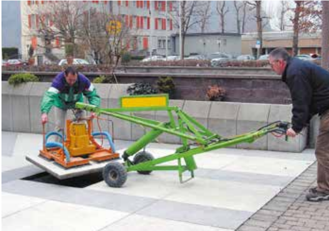
Plattenverlegegerät PRESTO
