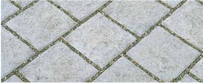
Versickerung durch aufgeweitete Fugen (Splittfuge)
