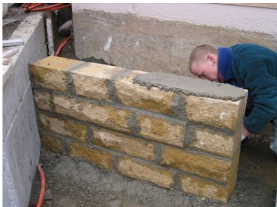
Bild 42 Aufbringen Mörtel für Abdeckplatte
