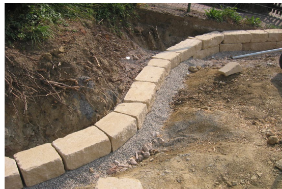
Bild 24: Versetzte erste Steinreihe in Kiesfundament
