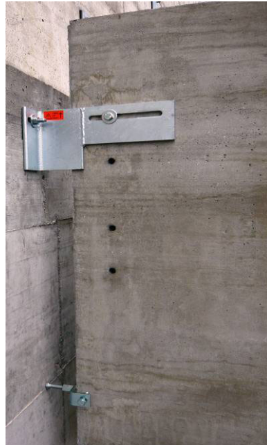
Bild 40: Befestigungswinkel Typ ISO A und Distanzhalter für Standardlichtschächte
