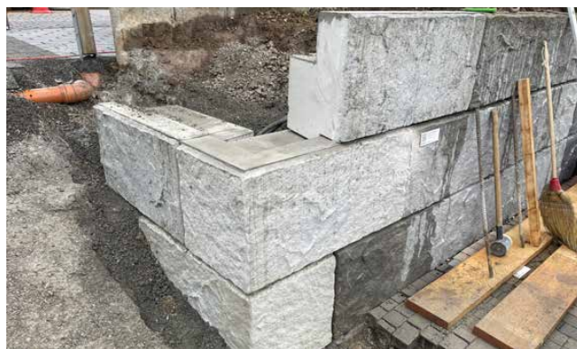
Illustration 24 : pose des éléments d'angle
