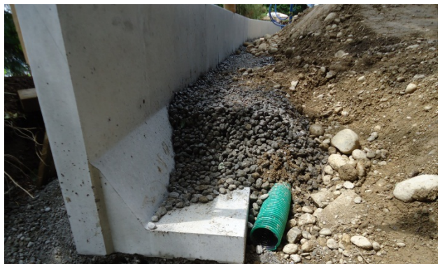
Bild 24: Einbau einer Sickerleitung
