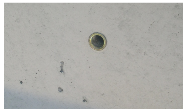
Bild 20: Werkseitig eingebaute Versetzhülse
