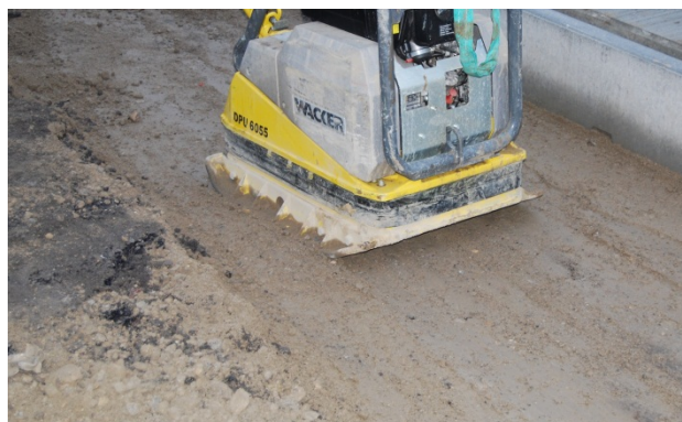
Bild 30: Verdichten nur mit sehr leichten Verdichtungsgeräten
