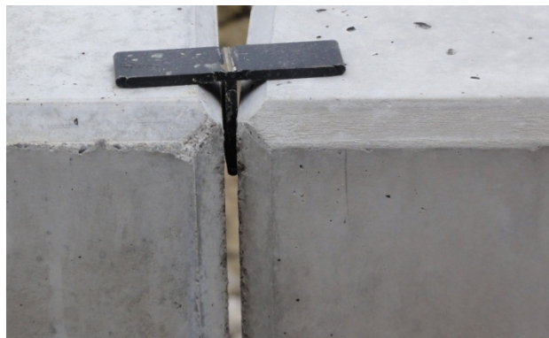
Bild 27: Optimale Fugen nach der Versetzung
