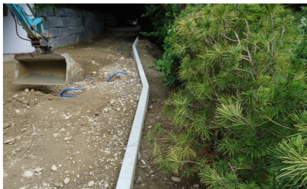
Bild 41: Lagenweises Einbringen von geeignetem Hinterfüllmaterial
