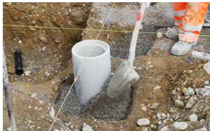
Erstellen der Punktauflager mit Betonrohren
