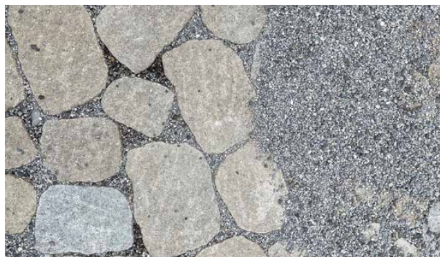
Sablage/gravillonnage des joints
