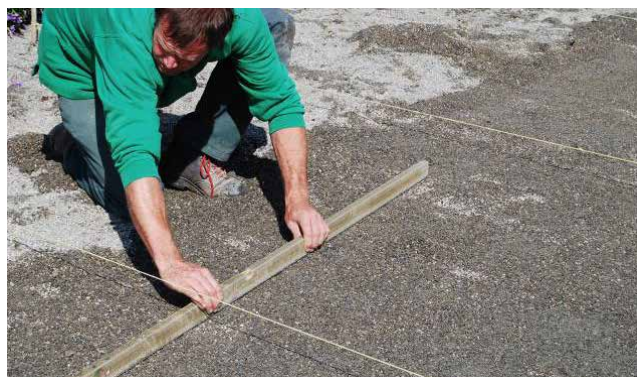
Nivellement du lit de pose
